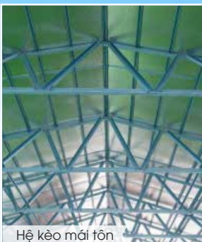
Hệ kèo mái tôn
